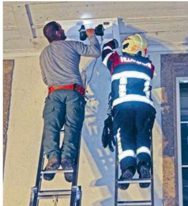
Im Teamwork werden die Nistkästen in luftiger Höhe montiert
