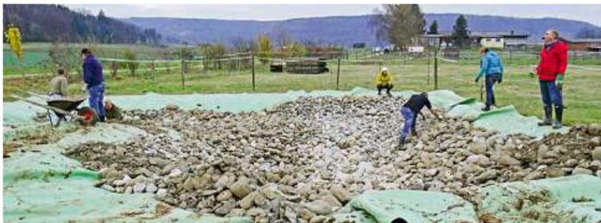
Die vorbereitete Grube wird am Ende des Arbeitstages zu einem Feuchtbiotop
