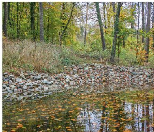
Der 2016 gebaute Teich oberhalb des Itelebachs BILD: BHE
