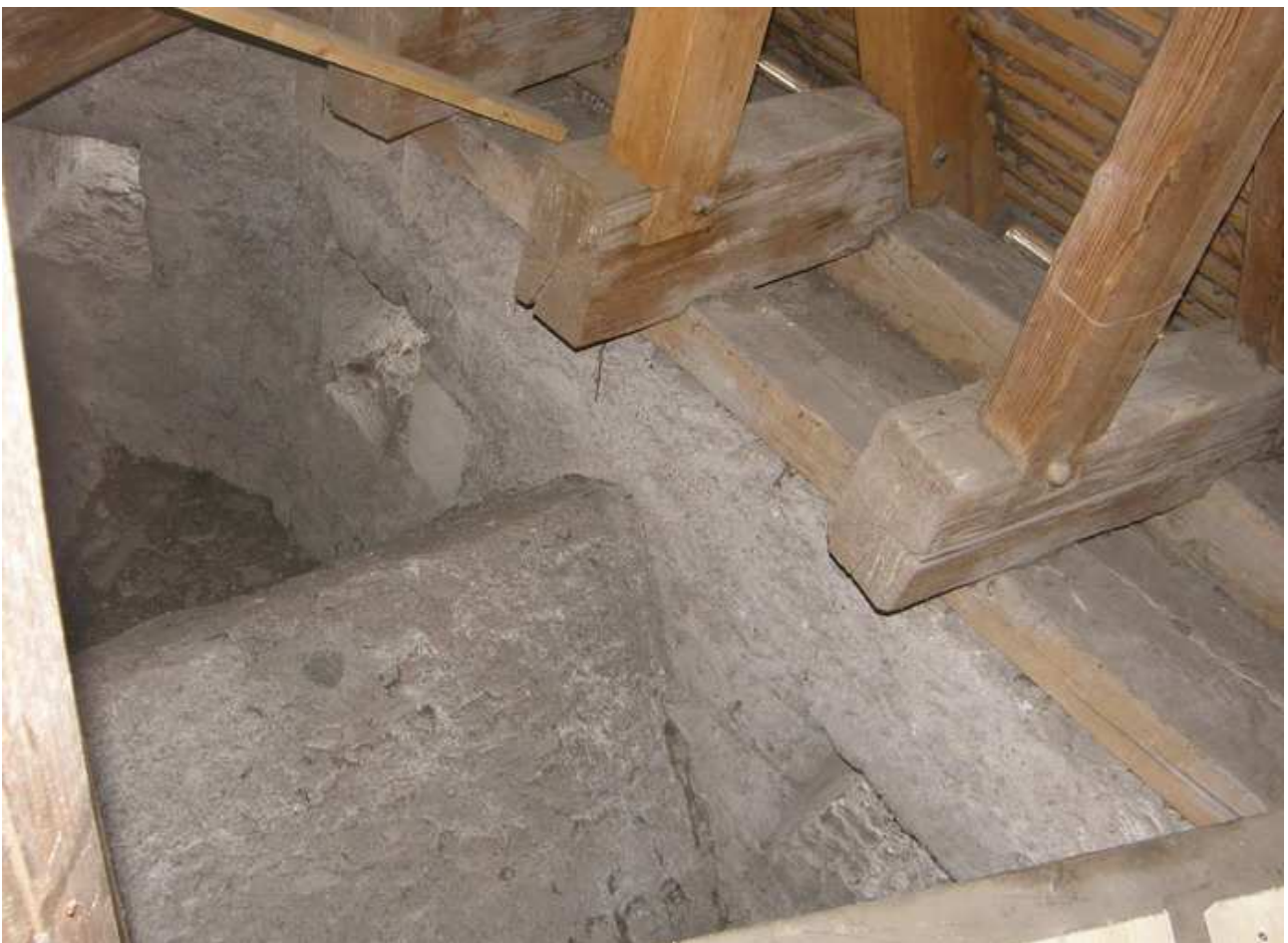
Über den Chor - Bögen hatte es tiefe Abgründe, welche für eine Kontrolle so nicht begehbar waren.
