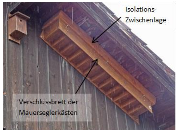
12er-Kästen am Werkhof Brugg mit Isolation und Verschlussbrett für die Winterzeit (Bild: B. Herzog)
